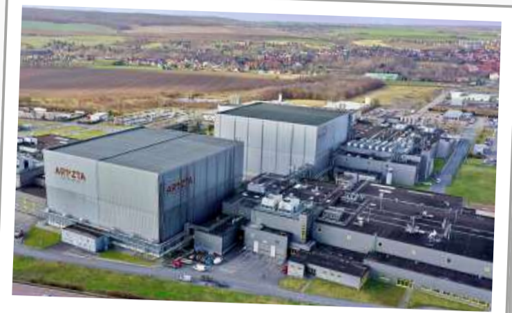
Aryzta in Eisleben ist mit 1.700 Mitarbeitern einer der größten und modernsten Backwarenhersteller in Europa.
